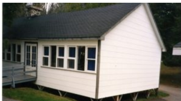
Bâtisse originale construite en 1964
